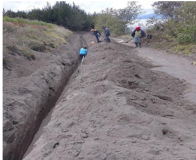
Mingas excavación para colocación de tubería de agua de consumo humano
