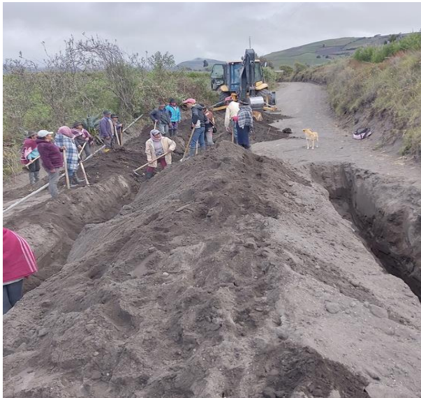
Mingas excavación para colocación de tubería de agua de consumo humano
