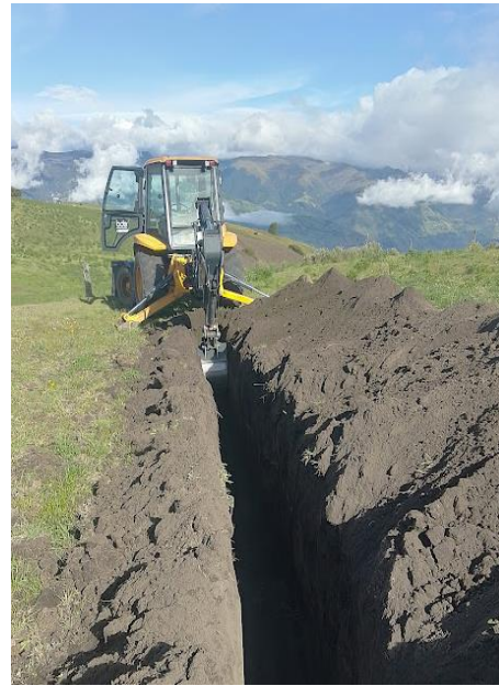
Mingas excavación para colocación de tubería de agua de consumo humano
