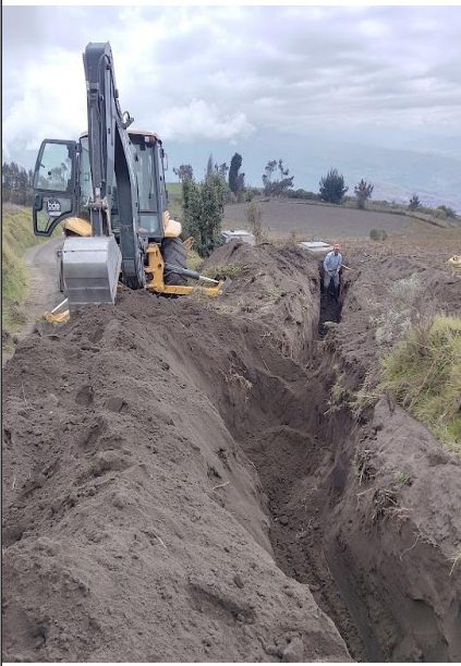
Mingas excavación para colocación de tubería de agua de consumo humano
