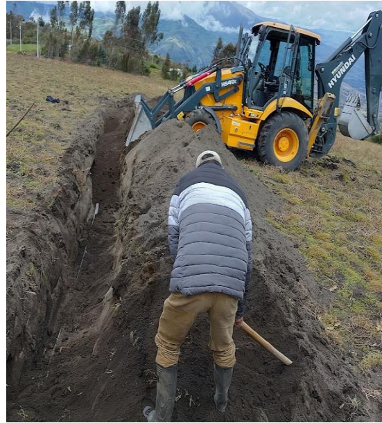
Mingas excavación para colocación de tubería de agua de consumo humano
